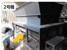
バイオマスボイラーの仕様は以下の通りである。通常時は、バイオマスボイラーのみで蒸気を供給しており、化石燃料ボイラー（重油貫流ボイラー）はメンテナンス等でバイオマスボイラーを停止する際に稼働している。なお、2号機は、負荷の調整が難しいためフル稼働させ、余剰蒸気を蒸気発電機で利用している（蒸気圧力を感知し、自動で蒸気を発電機に供給）。
