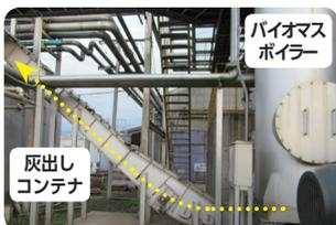
バイオマスボイラーの仕様は以下の通りである。通常時は、バイオマスボイラーは工場側の蒸気圧力に応じた供給燃料量制御で稼働(負荷率は50~100%の間で変動)し、一定圧力を下回ったときは自動的に化石燃料ボイラー(A重油貫流ボイラー)が稼働している。バイオマスボイラーの依存率は発熱量ベースで99%以上となっており、基本的にはバイオマスボイラーのみで負荷変動に対応できている。
