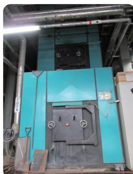
また、より一層の省エネルギーを図るため、2012年に、バイオマスボイラーの余剰熱回収システムを経済産業省「エネルギー使用合理化事業者支援事業」による補助を受けて導入した。それにより、余剰蒸気の熱で温水をつくり(約30℃の水を70~90℃くらいまで加温)、蓄熱温水タンクに貯蔵し、翌日の洗濯用温水に利用している。
