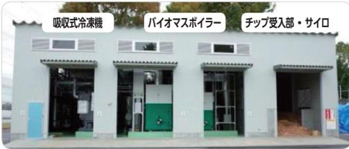
吸収式冷凍機の導入により、暖房、給湯だけでなく、冷房にも対応したシステムとしたことで、年間を通じてバイオマスボイラーが稼働するようになっている。
