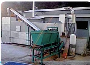
バイオマスボイラーの仕様は以下の通りである。通常時は、バイオマスボイラーを工場側の蒸気圧力に応じた燃料供給量制御で稼働させており、負荷変動にも対応できている。バックアップとして化石燃料ボイラー(重油貫流ボイラー)もあるが、ほとんど稼働することはない。
